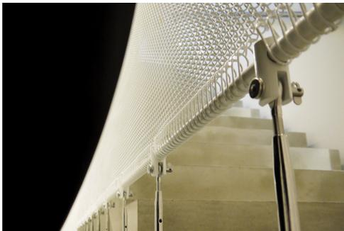
Die transparente und stockwerkverbindende Treppenhausverkleidung kombiniert Funktionalität und Design in hervorragender Weise. Sie ist an einem Stück gefertigt und misst 16 Meter an Höhe und 8,4 Meter an Breite.
